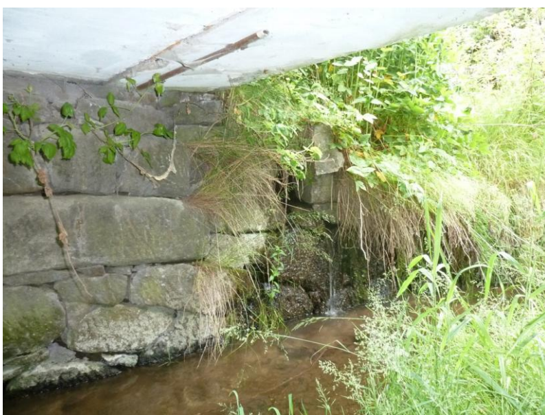
Navázání pravé opěry na regulační zeď na vtoku
